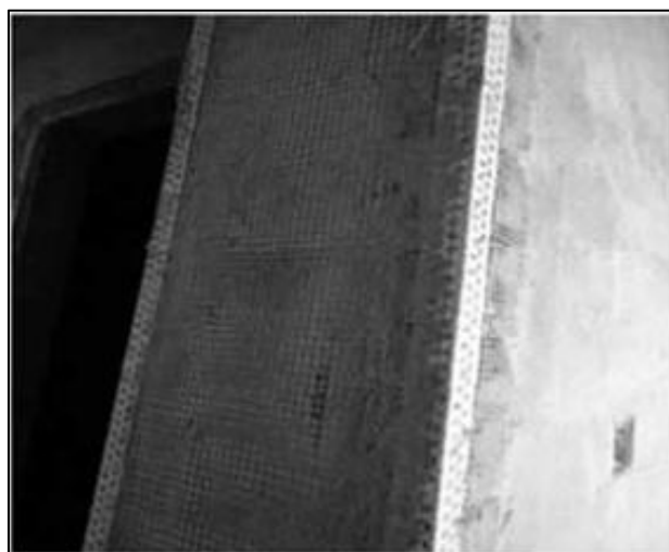
图 4.1.2-3 转角处、墙面粘结塑料护角及网格布参考做法
