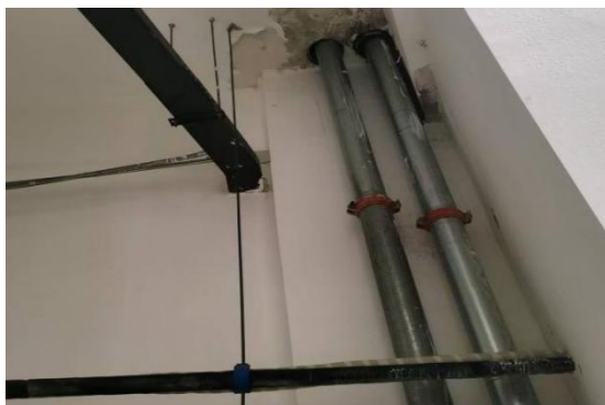
图 1.5.3-2 出屋面管道根部渗漏
