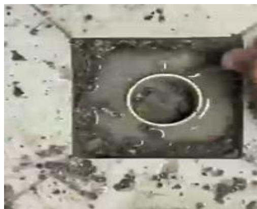
图 1.4.4-2 地漏口渗漏
