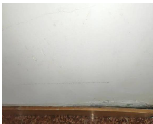
图 5.3.3-1 踢脚线安装不平整
