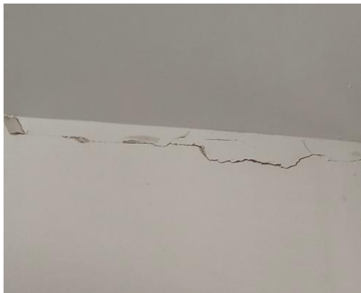
图 4.2.2-1 梁底填充墙开裂
