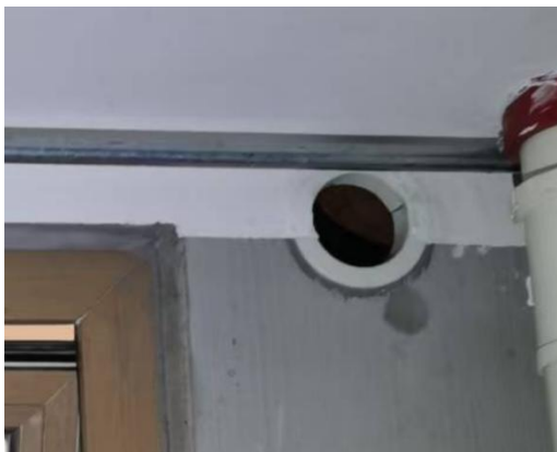
图 1.1.2-1 外墙洞口周边渗漏
