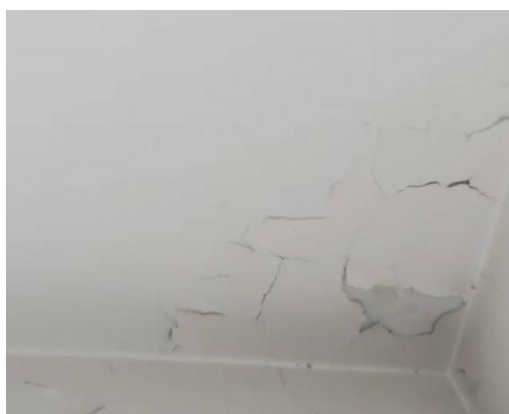
图 4.3.4-1 顶棚涂料开裂图
