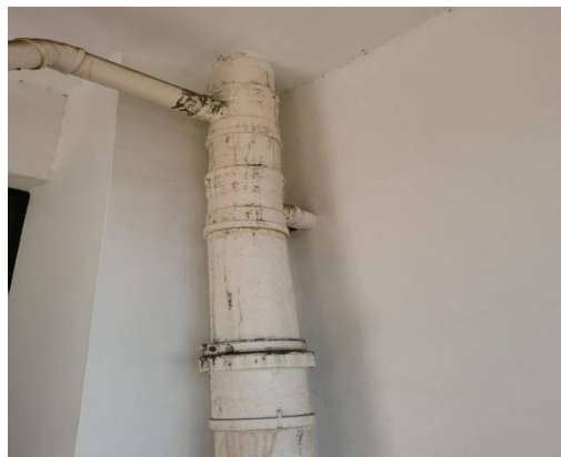
图 2.3.2-2 非消音管且无隔音措施
