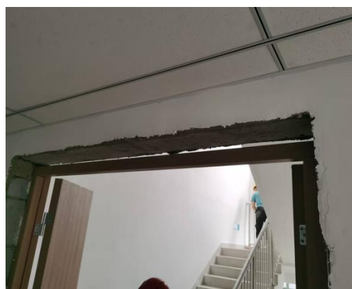
图 5.3.3-2 门下垂、套线脱落
