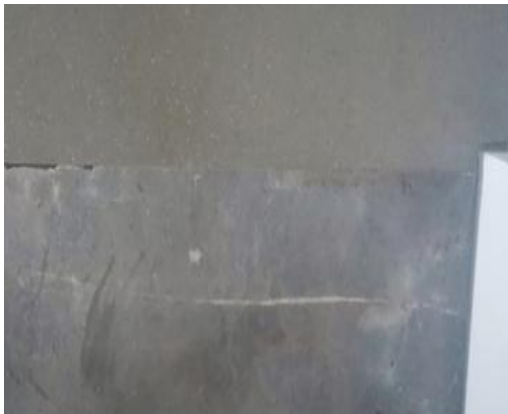
图 5.2.2-1 石材划痕破损
