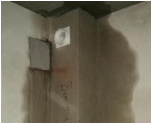
图 1.4.2-1 排气道根部渗漏
