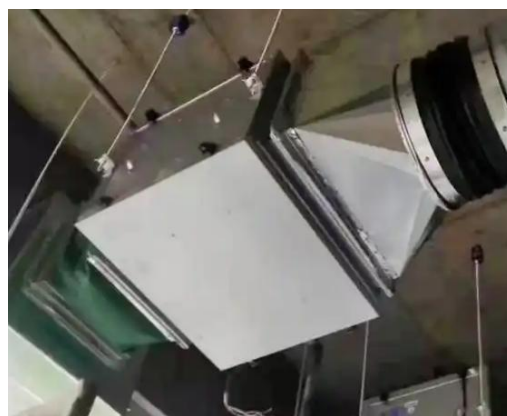
图 2.3.1-2 新风机吊装未设置减振措施
