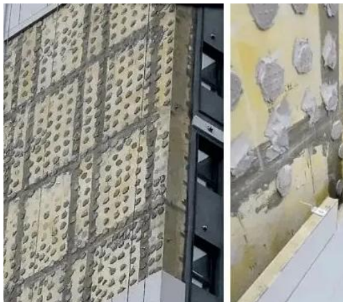
图 4.4.2-2 保温装饰一体板脱落
