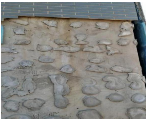
图 4.4.1-1 保温板从基层剥离脱落
