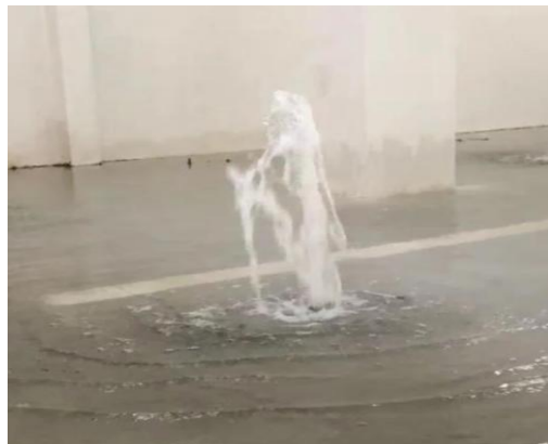
图 1.3.3-2 地下室降水管井渗漏
