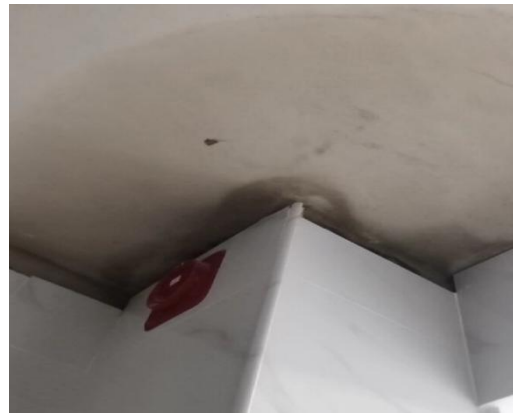
图 1.4.2-2 排气道根部渗漏
