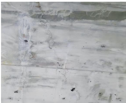
图 1.3.4-1 地下室侧墙开裂渗漏
