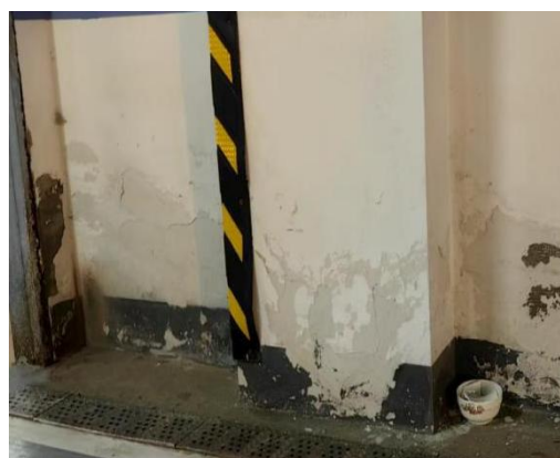
4.3.4-2 地下室涂料开裂、脱落
