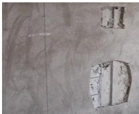
图 4.1.2-2 砌筑墙体抹灰层空鼓
