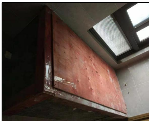
图 5.2.3-3 浴缸原包装盒反套
