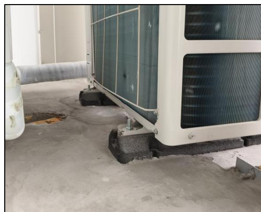
图 2.3.1-4 空调外机成品减振垫安装效果图
