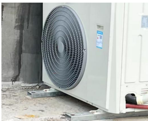
图 2.3.1-1 空调外机未设置减振措施
