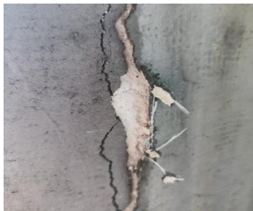
图 3.1.1-2 烟道本体开裂漏气漏烟
