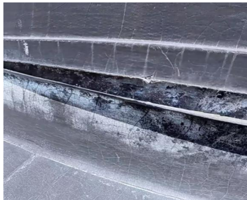
图 1.5.2-2 女儿墙防水层收头处破损
