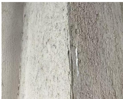
图 4.1.2-1 混凝土墙面砂浆抹灰层空鼓
