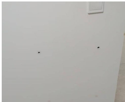
图 1.1.2-2 穿墙螺杆洞处渗漏
