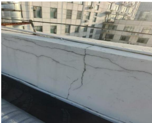
图 1.5.2-1 女儿墙压顶破损图
