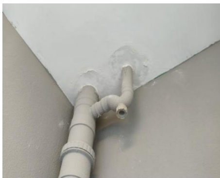
图 1.5.3-1 出屋面管道根部渗漏
