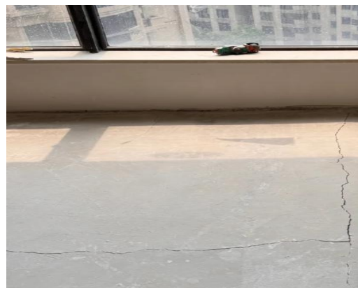
图 4.3.3-2 室内找平层开裂
