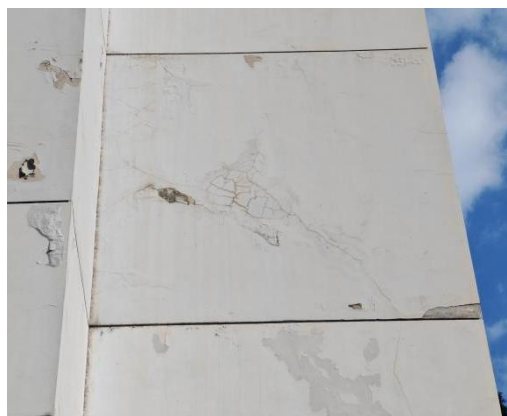
图 1.1.1-2 防水层开裂失效
