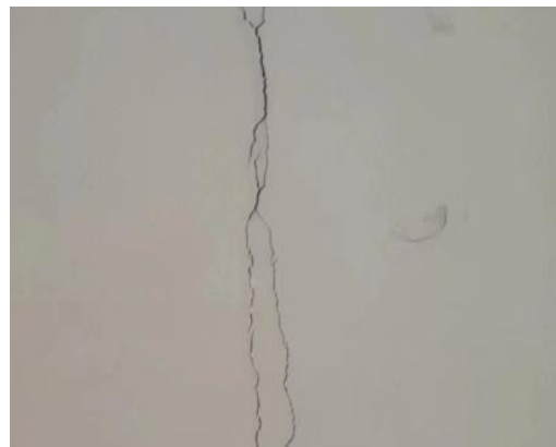
图 4.3.1-2 墙板接缝开裂
