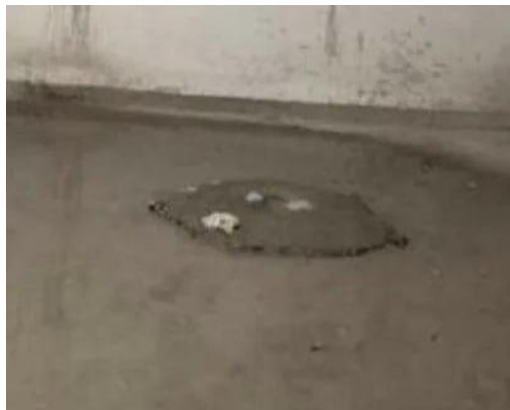
图 1.3.3-1 地下室降水管井渗漏
