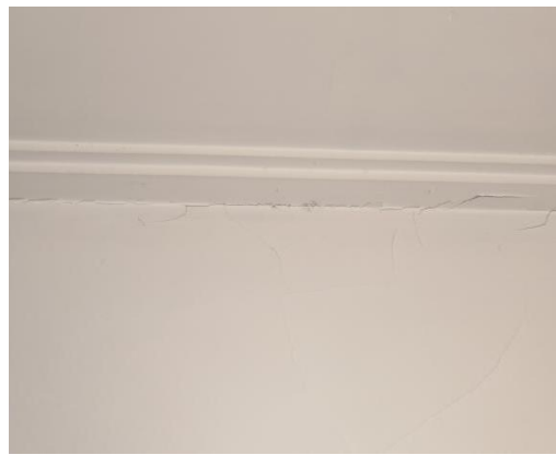
图 4.3.2-2 吊顶接缝开裂
