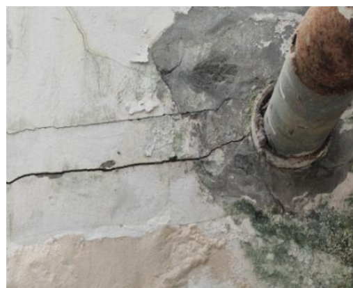
图 1.4.1-2 套管与管道间缝隙渗漏
