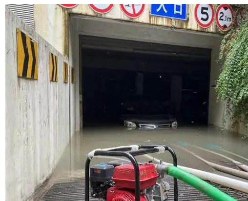
图 1.3.5-2 雨水倒灌
